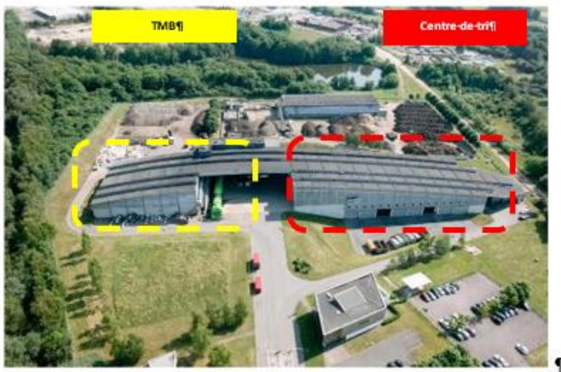
Figure 1 : Vue aérienne centre de traitement de déchets de Torcy
